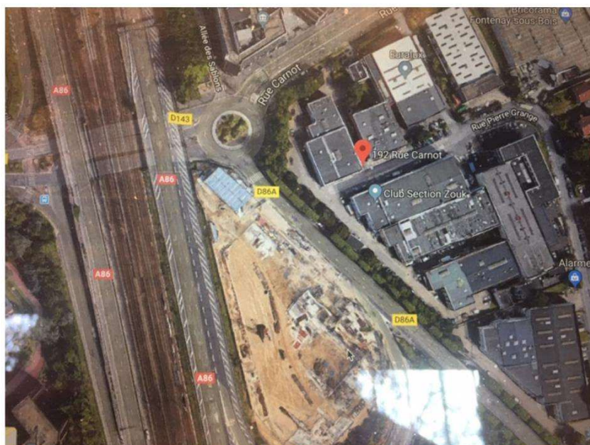
Après destruction des espaces verts
